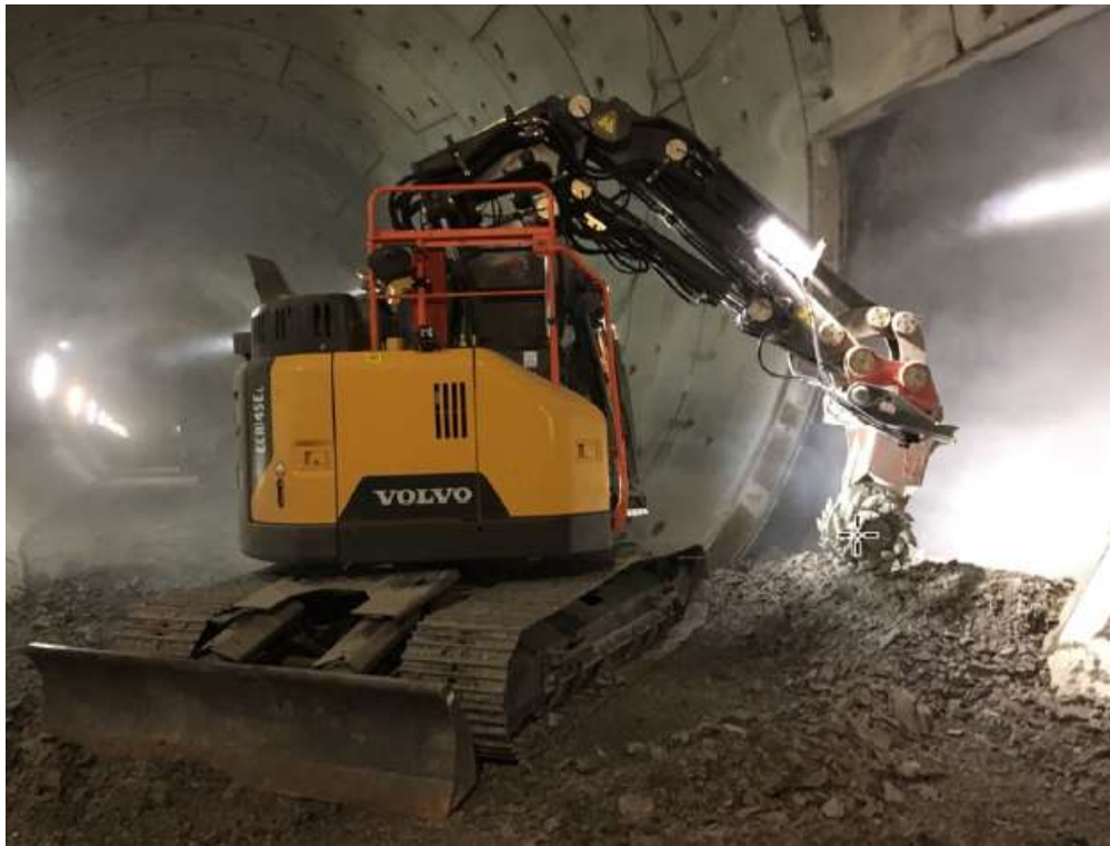
Volvo-Tunnelbagger ECR145E beim Vortrieb der Verbindungsstollen im Albvorlandtunnel
