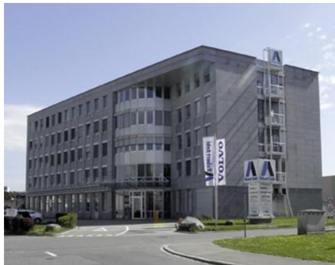
Das moderne Bürogebäude der Robert Aebi AG in Regensdorf
