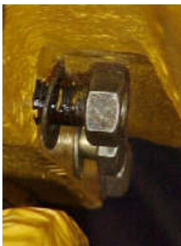
Lose Schrauben in der Verbindung zwischen Verteilergetriebe und Kupplungsgehäuse.
